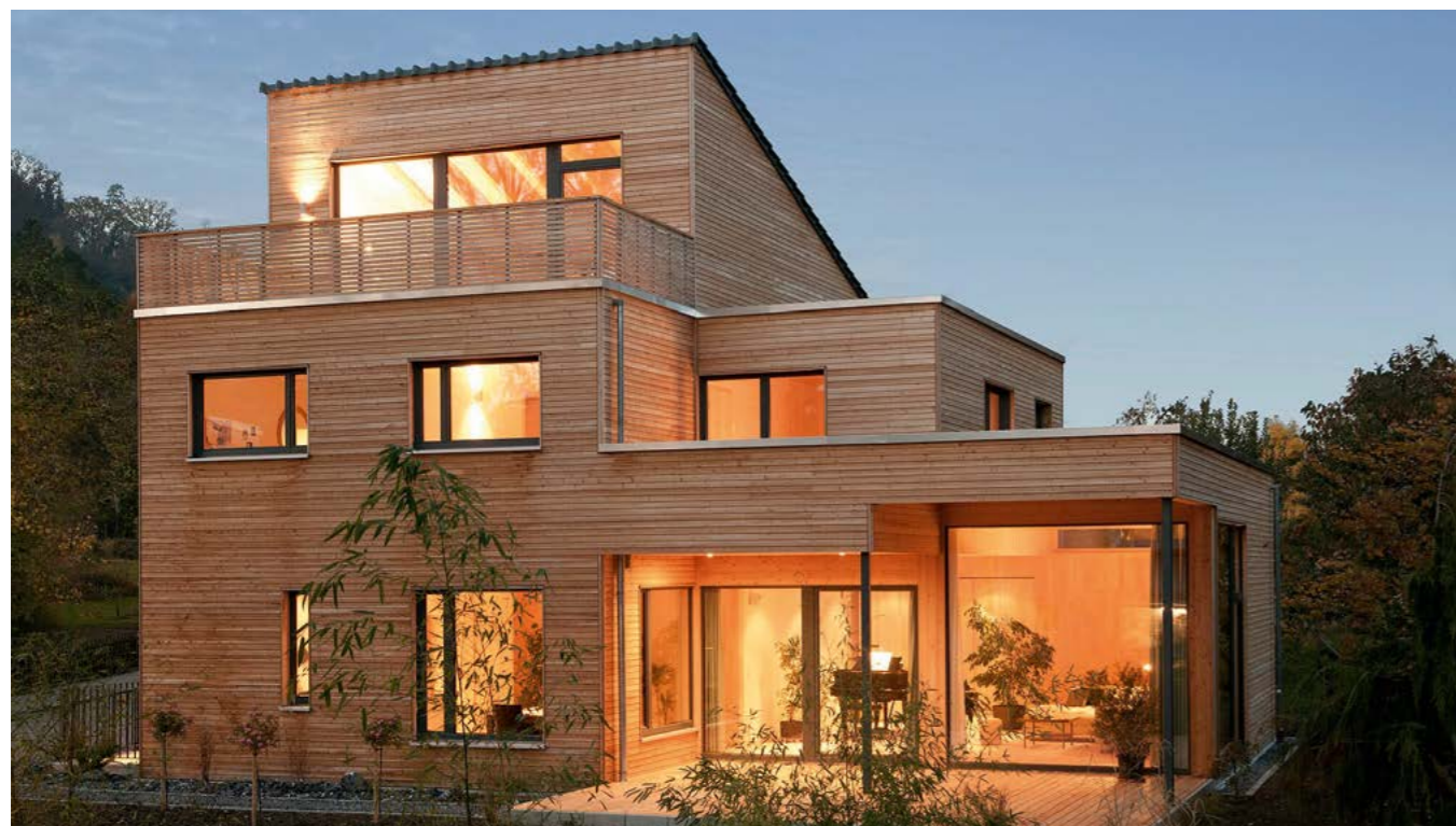
Bilder Seite 18 und 19: Den Häusern von HolzHaus Bonndorf liegt ein komplett leim- und folienfreier Wandaufbau zu Grunde.
